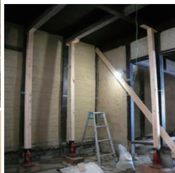
揚げ前：腐朽のため沈下した柱を元の状態に。
