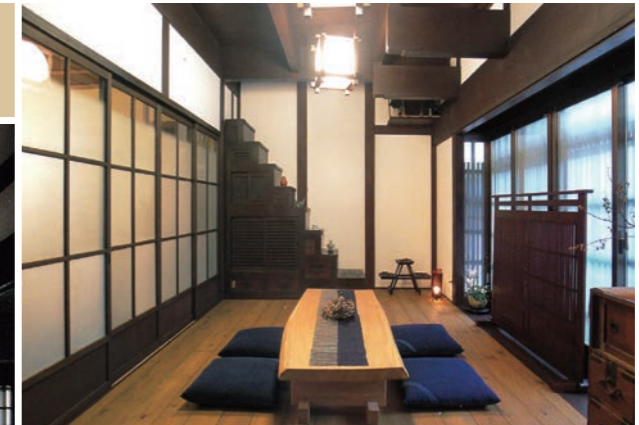
↑ 危ないからといって撤去した箱階段を飾り棚として再利用。
