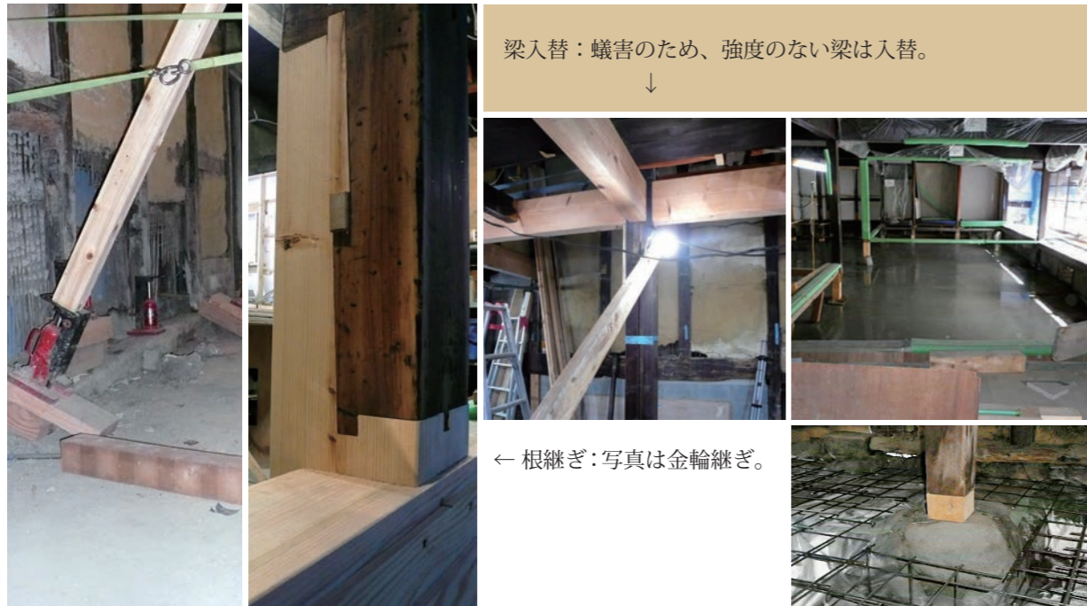
揚げ前：腐朽のため沈下した柱を元の状態に。
