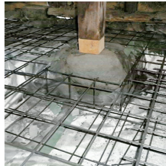
↑(上下) 基礎補強：工事後は地盤が下がらないように補強。一つ石も根巻き。
