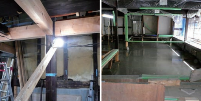
← 根継ぎ：写真は金輪継ぎ。
