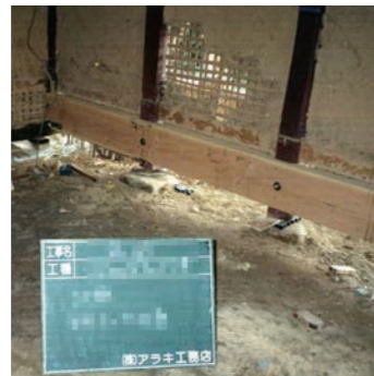
↑ 柱繋ぎ：柱と柱の足元を繋いで地震対策を施す。
