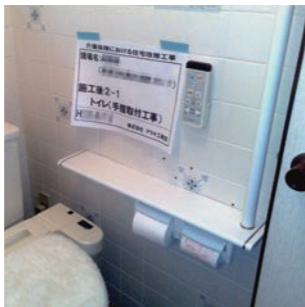
← トイレの改修
