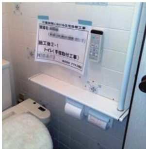
← トイレの改修
